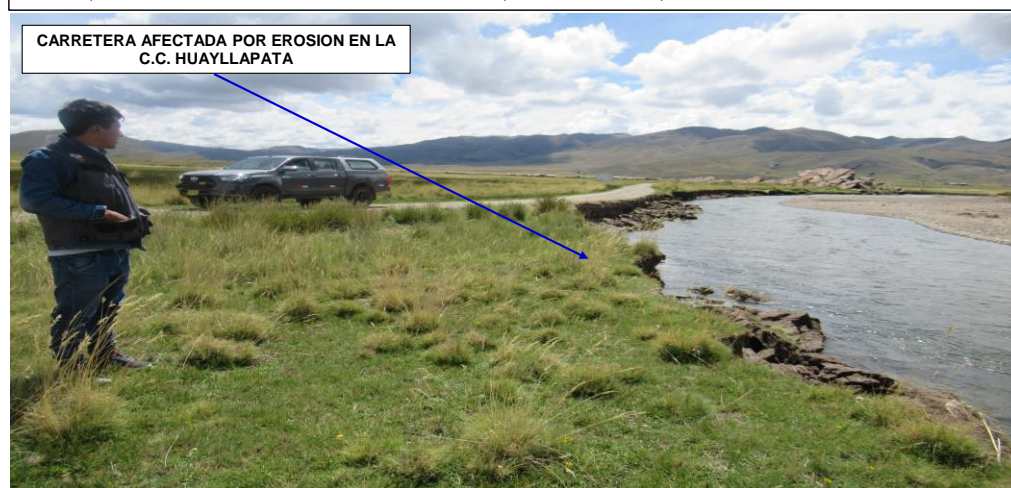
FIGURA N°02: TRAMO CRÍTICO II EN EL RÍO PUNCUNE ZONAS VULNERABLES A LA SOCAVACION DE LA RIBERA DEL RIO EN LA MARGEN DERECHA, AFECTANDO LA CARRETERA EN LA C.C. SAN FRANCISCO, DISTRITO DE PUTINA, PROVINCIA DE S.A. PUTINA - PUNO.
