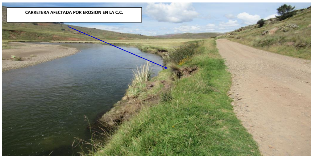
FIGURA N°03: TRAMO CRÍTICO II EN EL RÍO PUNCUNE ZONAS VULNERABLES A LA SOCAVACION DE LA RIBERA DEL RIO EN LA MARGEN DERECHA, AFECTANDO LA CARRETERA EN LA C.C. SAN FRANCISCO, DISTRITO DE PUTINA, PROVINCIA DE S.A. PUTINA - PUNO.
