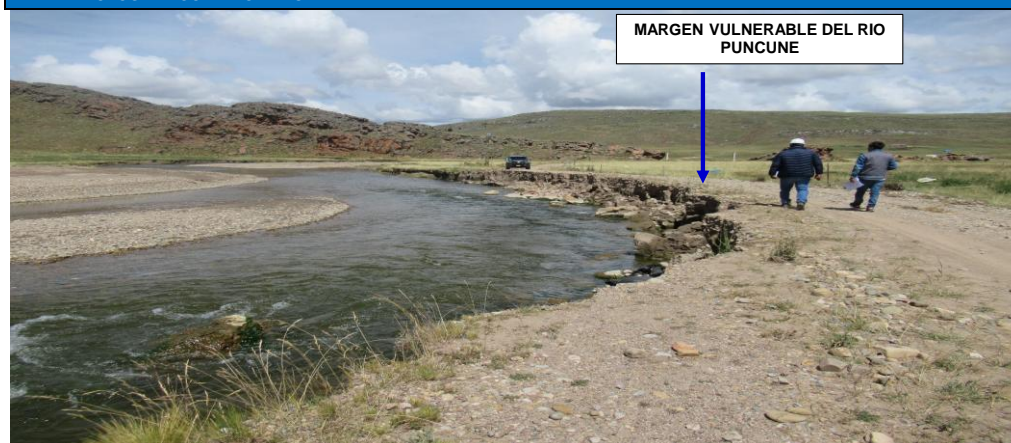
FIGURA N°01: TRAMO CRÍTICO I EN EL RÍO PUNCUNE ZONAS VULNERABLES A LA SOCAVACION DE LA RIBERA DEL RIO EN LA MARGEN DERECHA, AFECTANDO LA CARRETERA EN LA C.C. SAN FRANCISCO, DISTRITO DE PUTINA, PROVINCIA DE S.A. PUTINA - PUNO.
